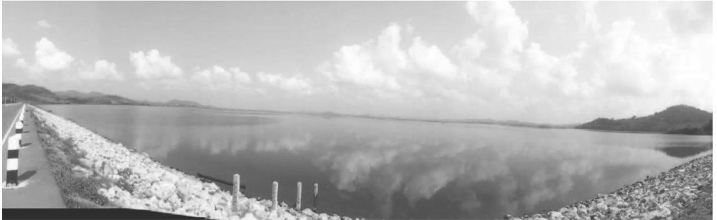
อ่างเก็บน้ำประเวศ
