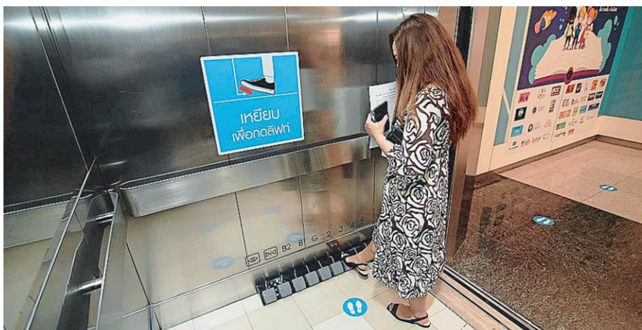
ลิฟต์เท้ากด ศูนย์การค้า ซิกอนสแควร์ ศรีนครินทร์ ตอบโจทย์คนกลัวโควิด-19 ด้วยการติดตั้งเป็นกดลิฟต์ด้วยเท้าแทนใช้นิ้วสัมผัส เพื่อป้องกันไวรัส.
